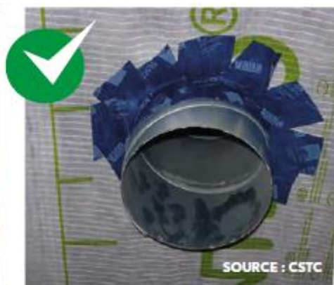
Pose radiale des bandes adhésives (solution satisfaisante)
