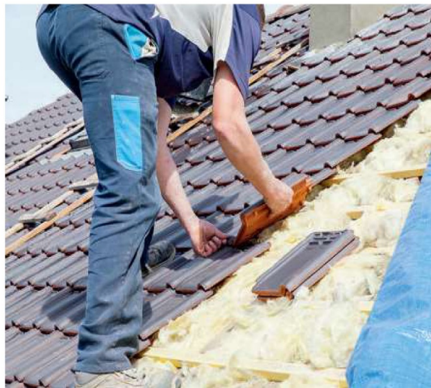
En 2050, le bâti wallon devra être complètement neutre en carbone. Il y a du boulot.
